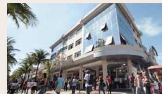
Rua Antônio Agú
